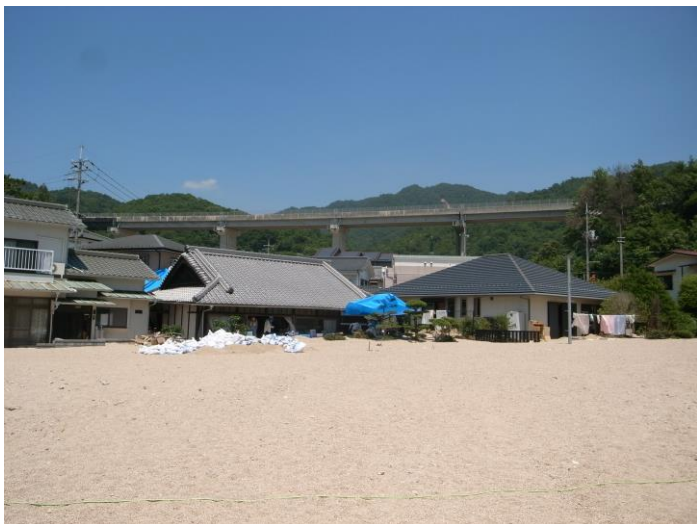
埋まった住宅 手前の砂浜は全て氾濫したまさ土の土砂
