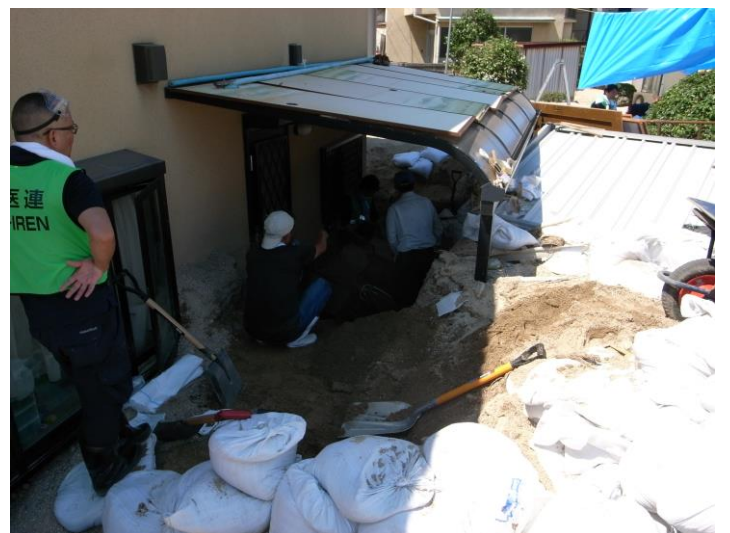
掘って掘って掘りまくって玄関を採掘する。途中自転車など異物に行く手を阻まれる
