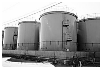
ずらりと並ぶタンク
